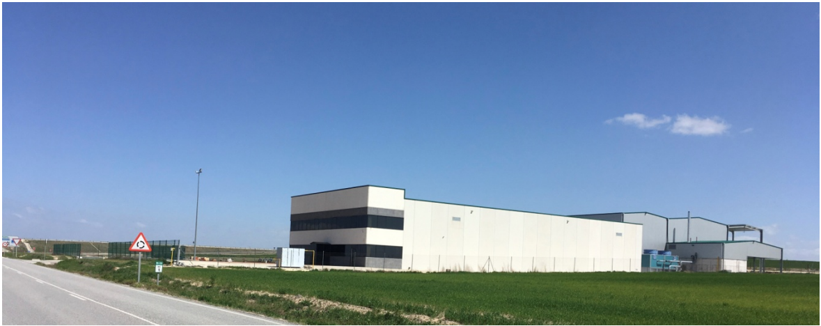
Vista desde el Oeste
